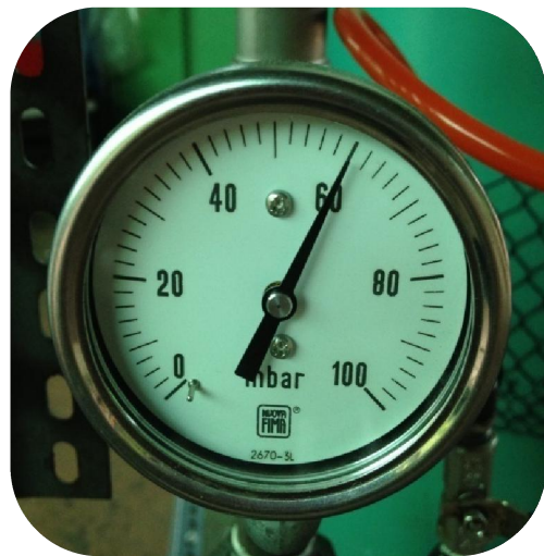
รูปที่ 10 แสดงการติดตั้ง Low Gas Pressure Regulator และ เกจวัดแรงดันก่อนเข้าอุปกรณ์ แรงดันตั้งสูงสุดไม่ควรเกิน 70 mbar สามารถปรับได้จาก Regulator
